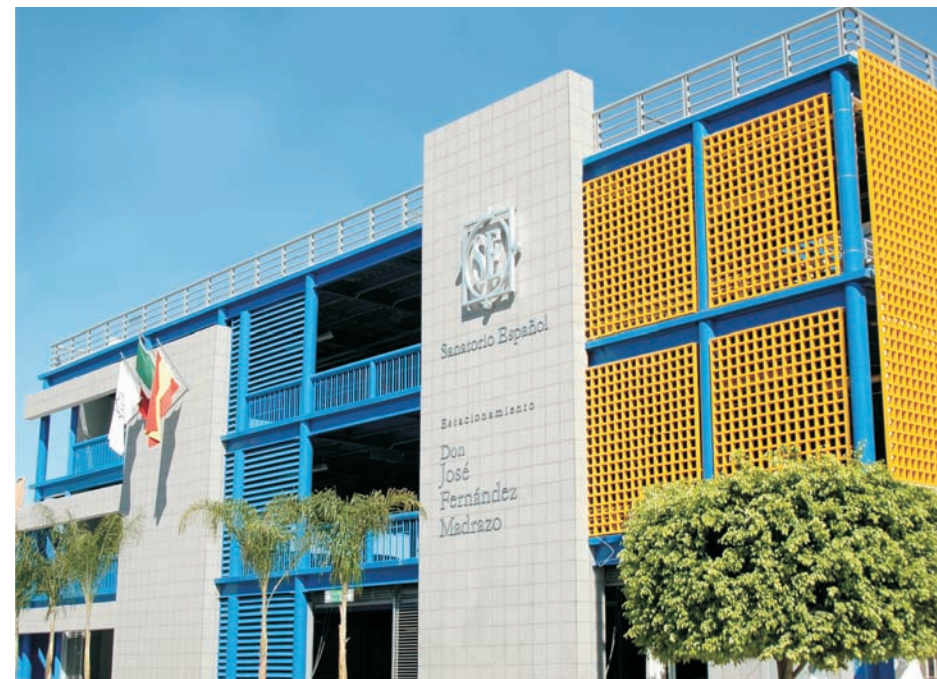
Estacionamiento José Fernández Madrazo Construido en el 2006.
